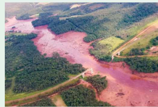
Rupture du barrage de Brumadinho au Brésil
